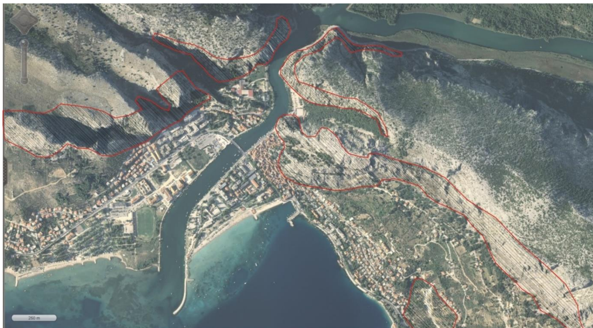
Slika 8. Područja odrona kamenja i klizišta
