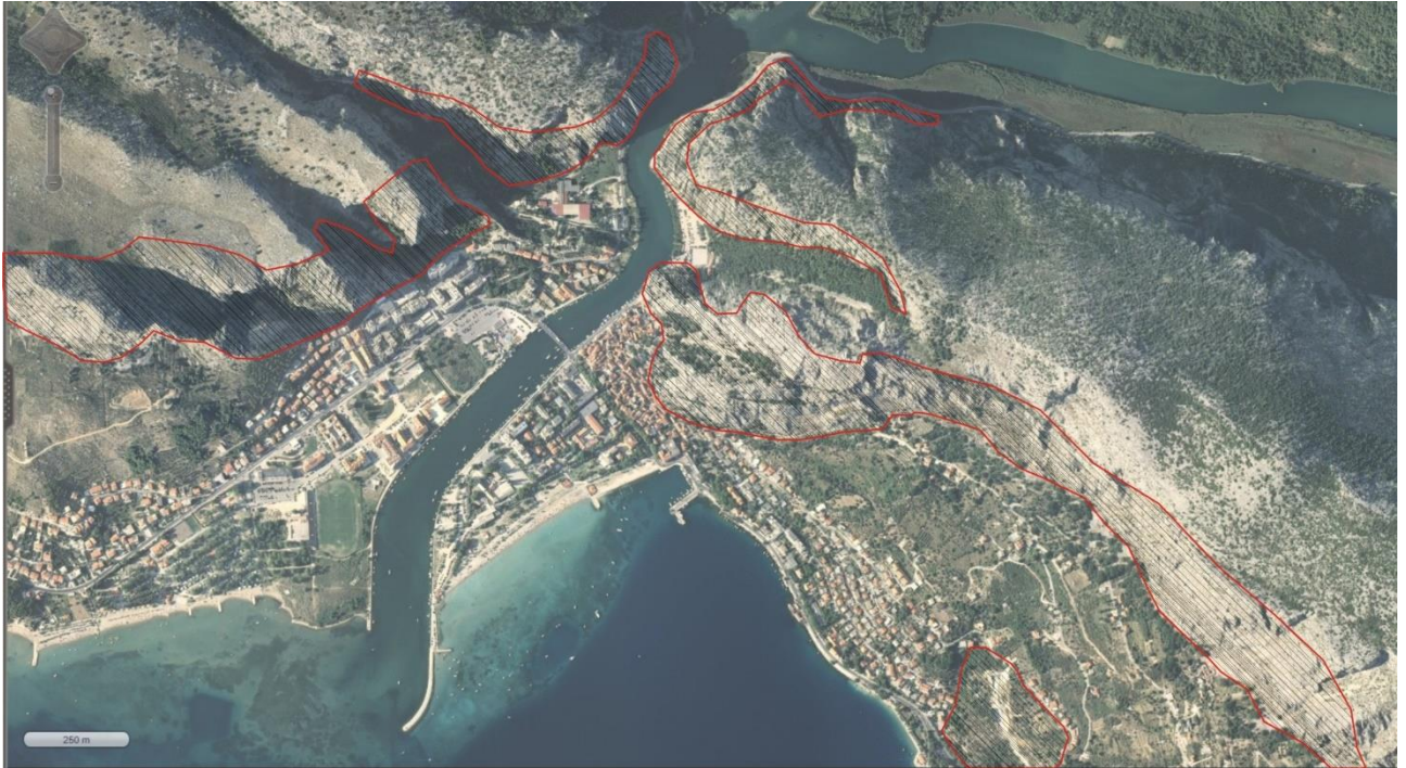
Slika 4. Područja odrona kamenja i klizišta
