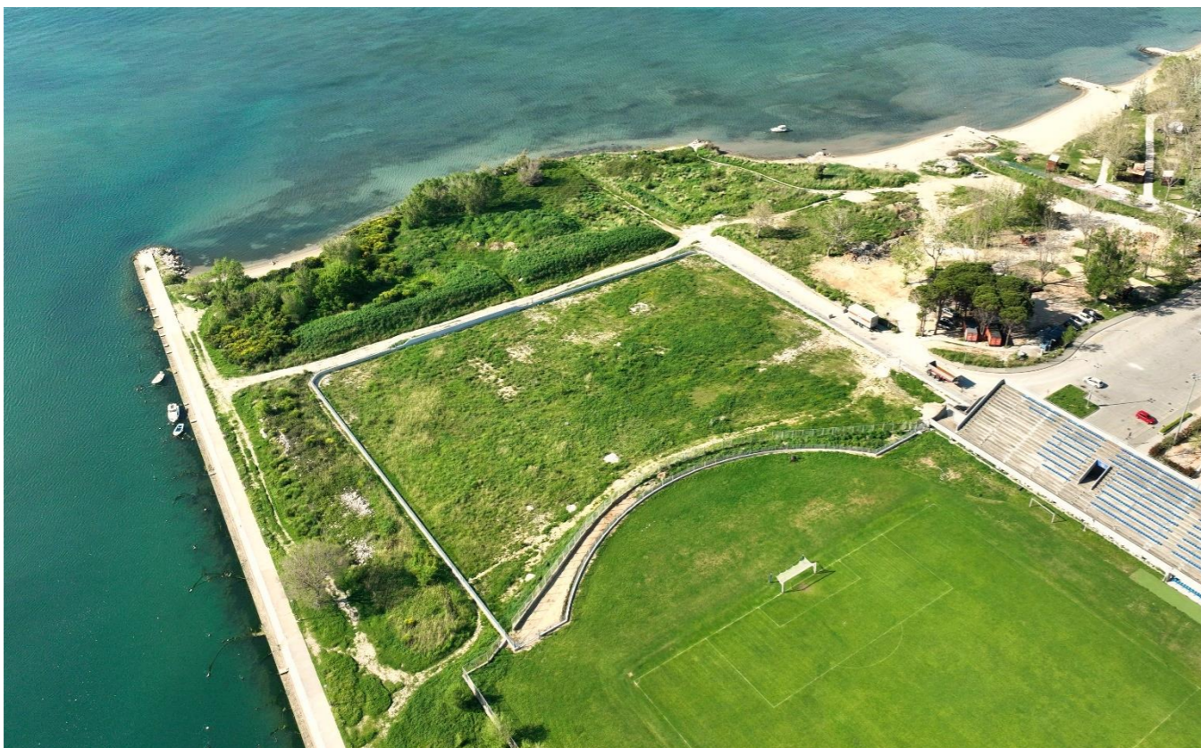
Sl. 75. Obrasto zemljište južno od stadiona
