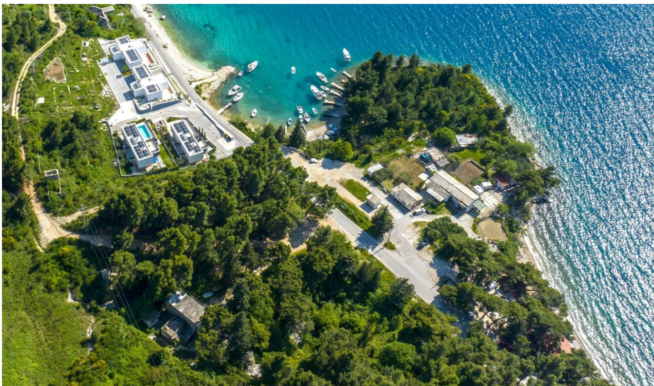
Sl. 69. Zaostali objekti na prostoru nekadašnje tvornice cementa Palaveršića
