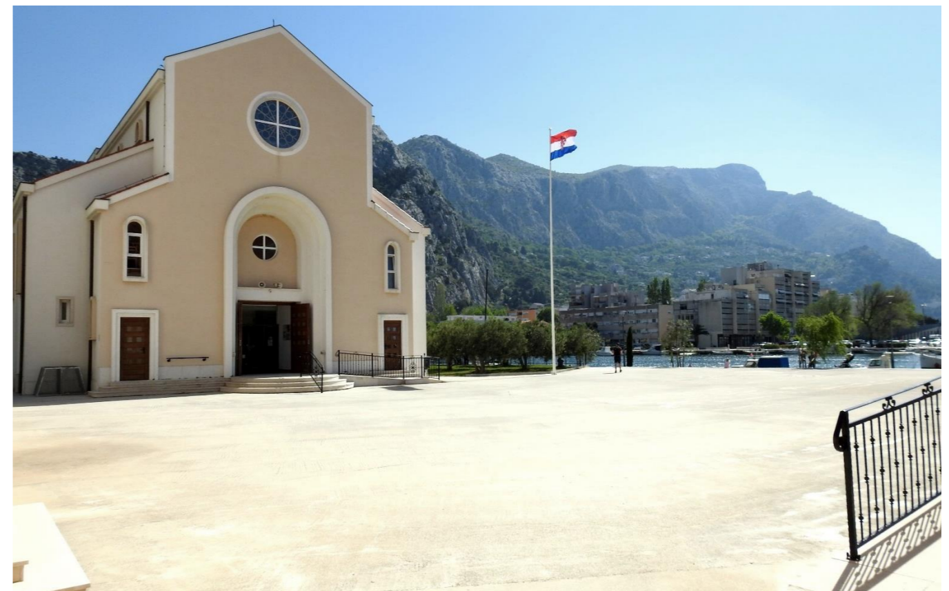
Sl. 92. Snažan odsjaj na asfaltiranoj površini bez vegetacije i hlada
