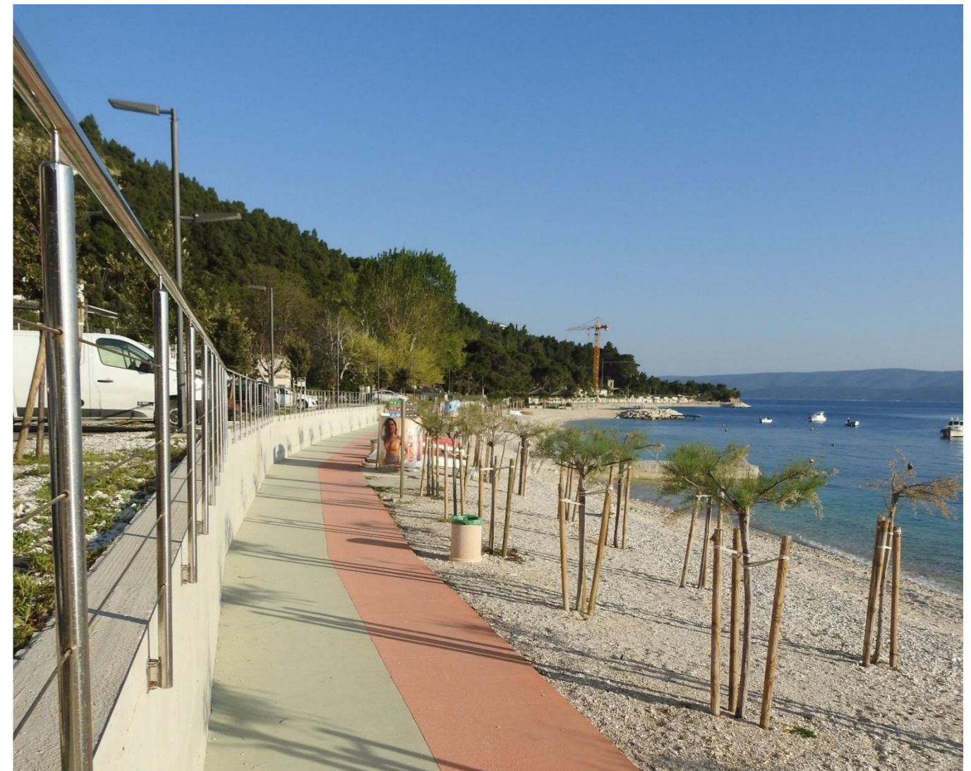
Sl. 45. Izvedena dionica dužobalne šetnice na plaži Brzetu
