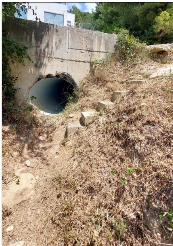
Slika 5. Propust bujice ispod lokalne ceste
